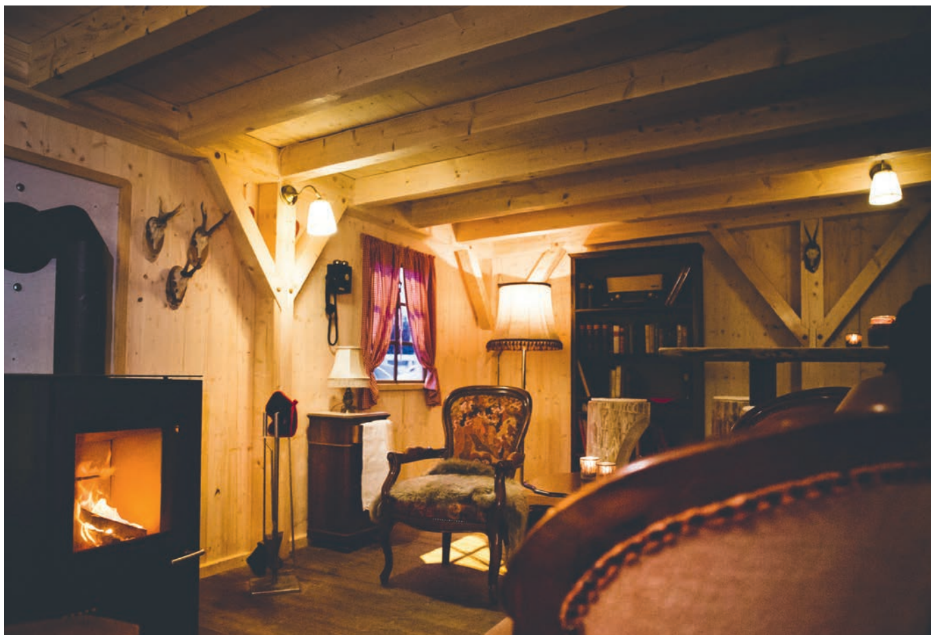
Heimelige Atmosphäre mit Holz: Wände und Decken sind wahlweise aus Dreischichtplatten in Fichte natur oder aus Altholzbrettern realisiert. Die Tragkonstruktion besteht aus Schweizer Brettschichtholz.
