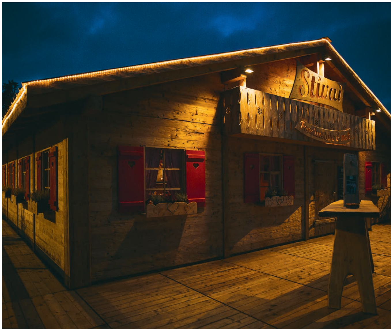
Die Produktion des Holzchalets dauert vier bis fünf Wochen, die Montage vor Ort ein bis drei Arbeitstage.
