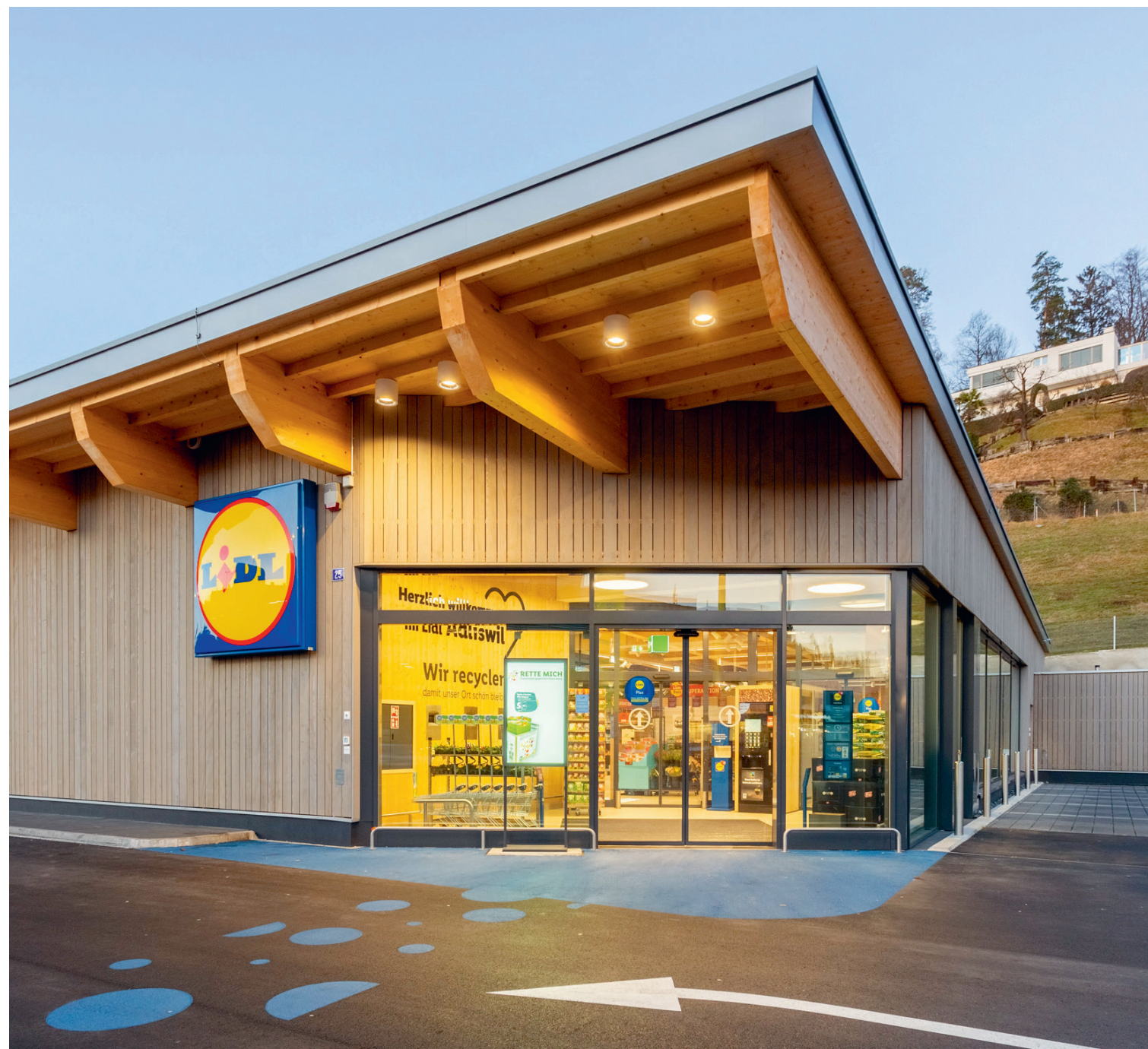
Die auskragenden, 84 Zentimeter hohen Binder markieren den Eingang zum Laden in Adliswil.
