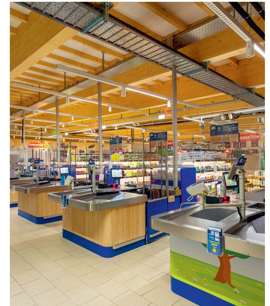
Ein Einkaufszentrum kann auch schön sein: Der Holzbau bildet 1200 Quadratmeter Verkaufsfläche.
