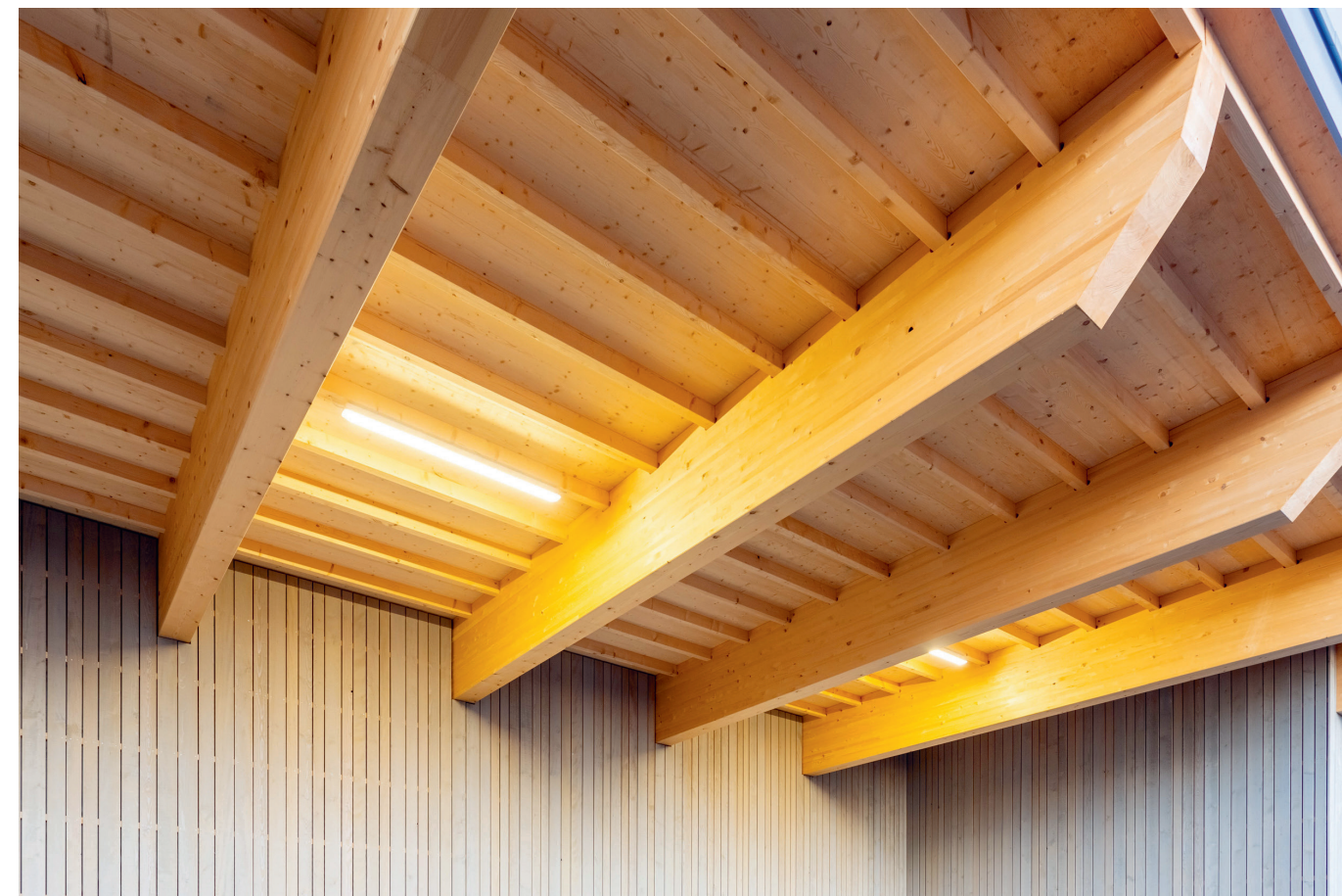
Binder im Achsabstand von 2,70 Metern und Koppelfetten bilden die Dachkonstruktion.
