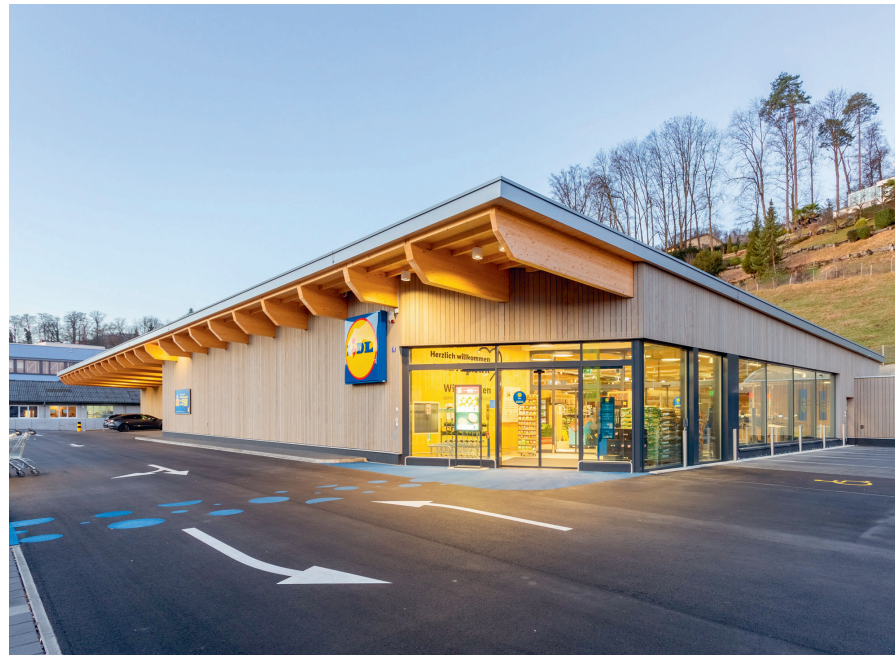
Die schlichte, ansprechende Architektur konnte schnell und wirtschaftlich umgesetzt werden.
